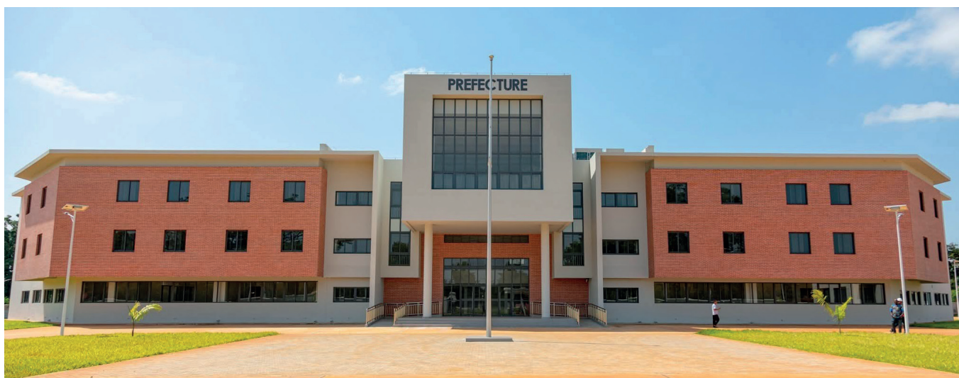
Bâtiment de la Préfecture au sein de la Cité administrative départementale d'Abomey
